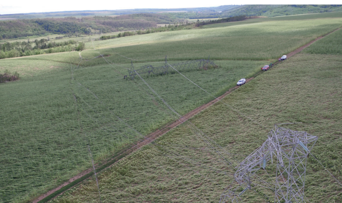
3.3. ábra. Szupercella által 2017. július 24-én megromgált 400 KV-os vezeték Pécs környékén. MAVIR drón felvétel.
